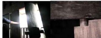
Pada bangunan ini menggunakan bukaan pada area timur bangunan jendela pada bangunan ini menggunakan sistem sambungan kayu dengan lebar bukaan 1,2 dan tinggi 2 m.
