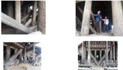
Gambar 14. Susunan Tiang kolom
