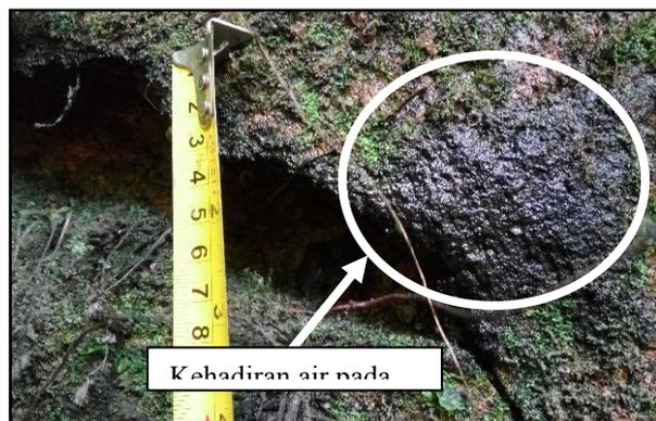
Gambar 4.7. Kehadiran air pada lereng
