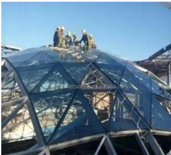
**Gambar 5-15** Konsep struktur bangunan grid shell
