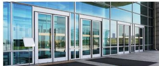
Gambar 73. Contoh Jendela dengan Frame Aluminium
