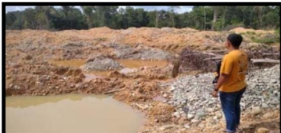
4. Rusaknya jalan desa yang dilalui oleh *excavator* penggali emas karena konstruksi jalan tidak dibuat khusus *excavator*, sebagian *excavator* memperbaiki kembali jalan yang telah dilewati.
