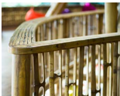
Gambar 3. Railing tangga yang dibuat dengan bambu Sumber : Dokumentasi Pribadi
